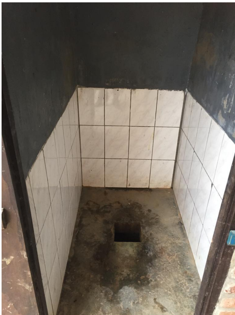
La condizione dei servizi igienici prima dei lavori
