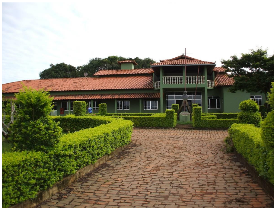
Il Nuovo Centro Don Orione dopo l'intervento Need You Onlus
